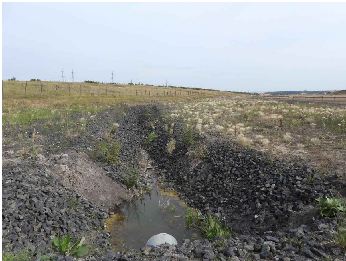
Opevnění odvodňovacích příkopů
