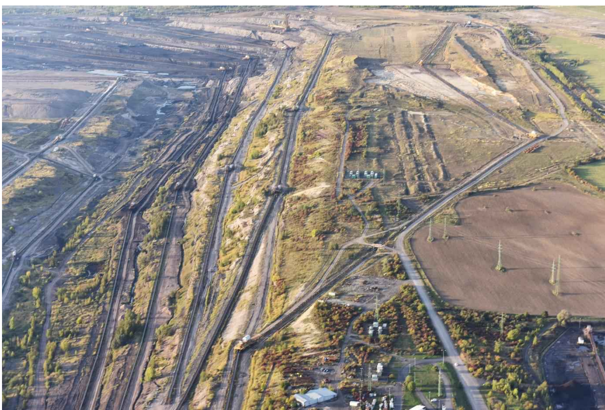
Probíhající činnost v předpolí lomu, přeložka komunikace a místo k budoucí selektivní skryvce ornice (2025)
